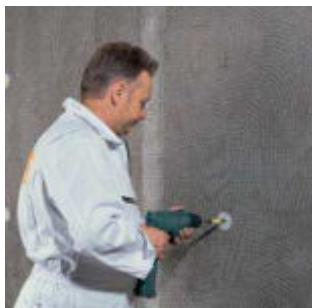
Затем через армирующую сетку PUG плиты крепят тарельчатыми дюбелями LOBATHERM и головки дюбелей шлаклиют RAS способом «мокре по мокрому». Минимальная общая толщина армирующего слоя составляет 7 мм.
