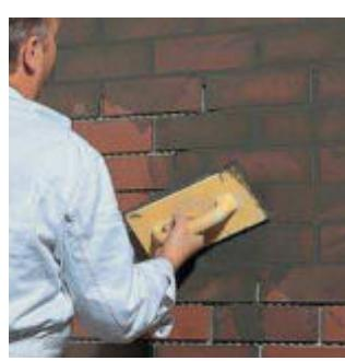
Швы закрытопористых плиток затирают Раствором-шламом RSS (точно так же как и кафельные плитки) с помощью губчатого шпателя ...
