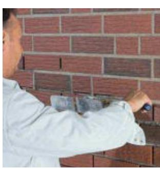
Швы открытопористых плиток заделывают Раствором для заполнения швов RFS с помощью расшивки и ...
