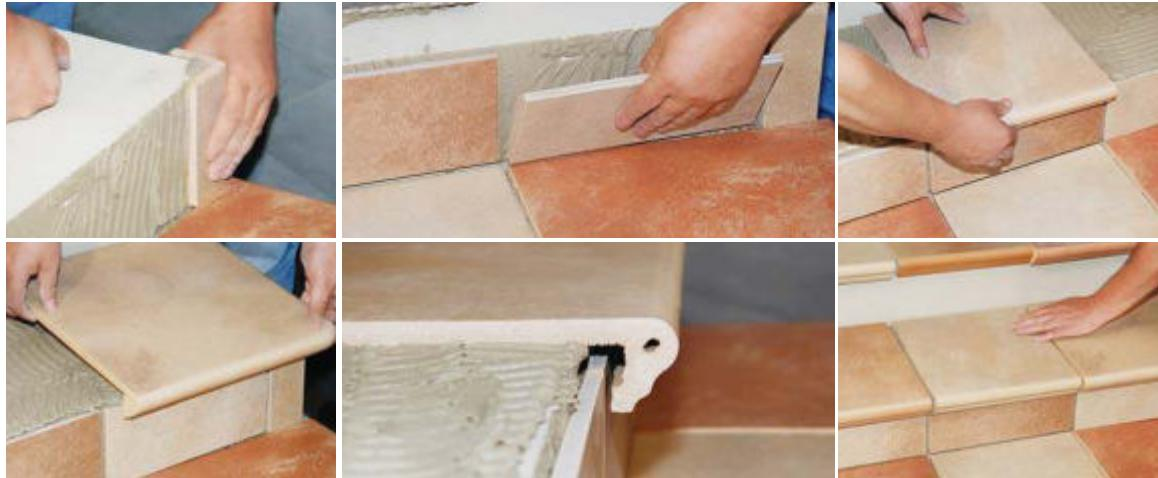
**Укладка ступеней на улице:** при укладке ступеней на улице выступающая часть не должна приклеиваться. Таким образом, можно избежать различных повреждений или трещин в результате возможных движений нижнего слоя основы.
